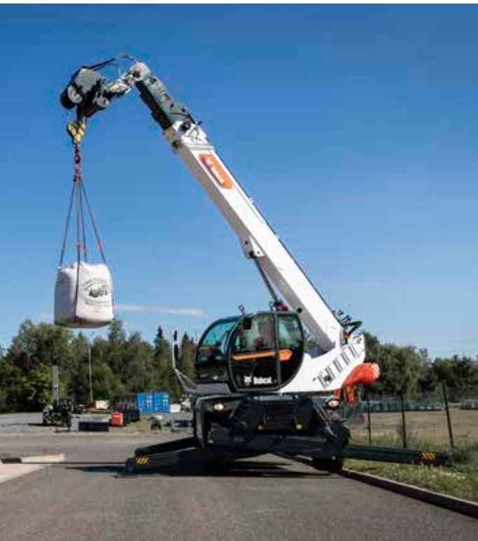
Vorinstallation für Seilwinde
